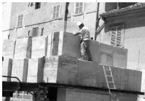
Interno ex Gil durante i lavori: la foto inedita ritrae il direttore tecnico della ditta Bioair (illegalmente presente in cantiere) Ernesto Pettirossi
